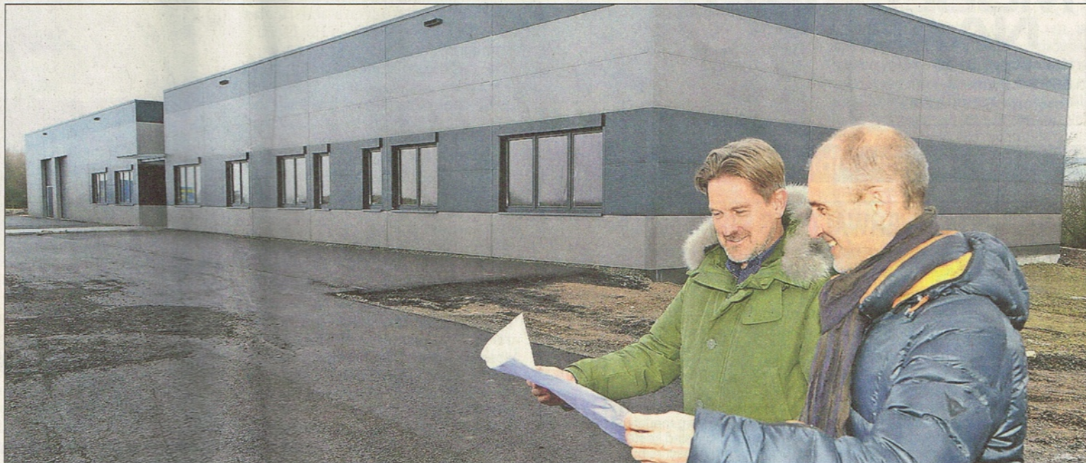
Im April ziehen sie ein, im Juli soll eine offizielle Einweihung stattfinden: die Bauherren Christian Bartens (links) und Uwe Mohrbach, Geschäftsführer der MB Systembau GmbH, vor ihrem neuen Firmendomizil in der Blocksbergstraße.
